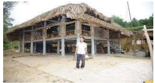
Nhà sàn khung BTCT ( Hàm Yên- Tuyên Quang)
